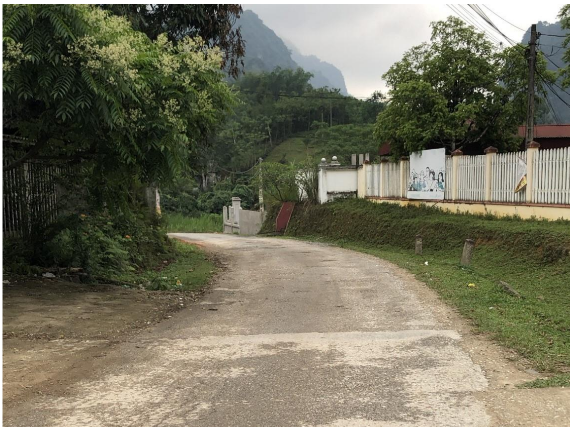
Hình 2.6. Hiện trạng tuyến đường Nước Hai- trung tâm xã
