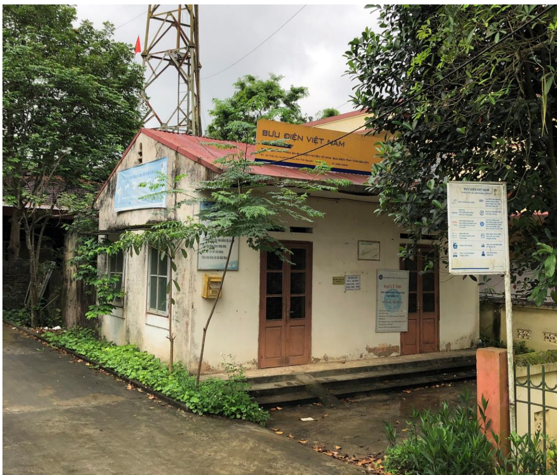
Hình 2.3. Hiện trạng Bưu điện văn hóa xã
