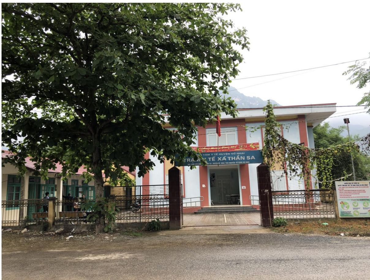
Hình 2.4. Hiện trạng trạm y tế xã
